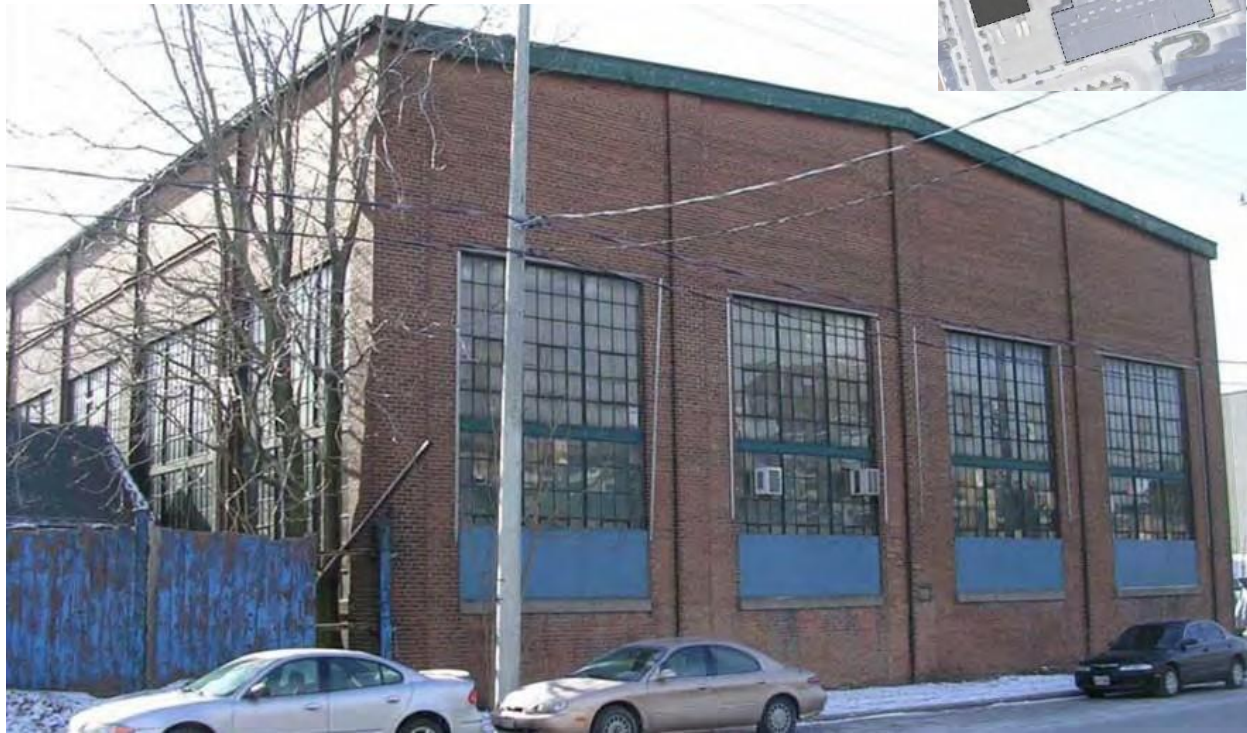
Figure 18 : Élévation nord (avant). Crédit : Commonwealth, 2008.
