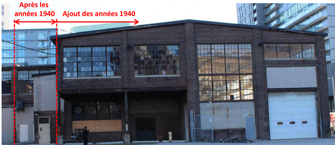
Figure 64 : 185 avenue Eastern – Atelier d'usinage de 1935 et ajout des années 1940 – Élévation sud. Crédit : SBA, novembre 2020.
