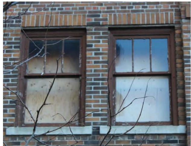
Figure 46 : Fenêtres d'origine – Élévation nord – Deuxième étage.
