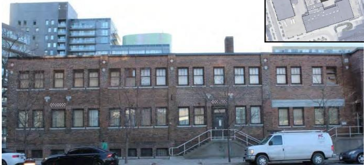
Figure 40 : 171 avenue Eastern — Élévation nord (avant), y compris le lien 1941. Crédit : SBA, novembre 2020.
