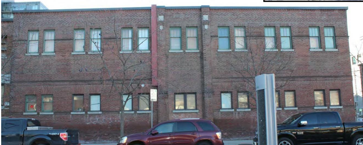
Figure 30 : 169 avenue Eastern – Entrepôt – Élévation nord (avant). Crédit : SBA, novembre 2020.
