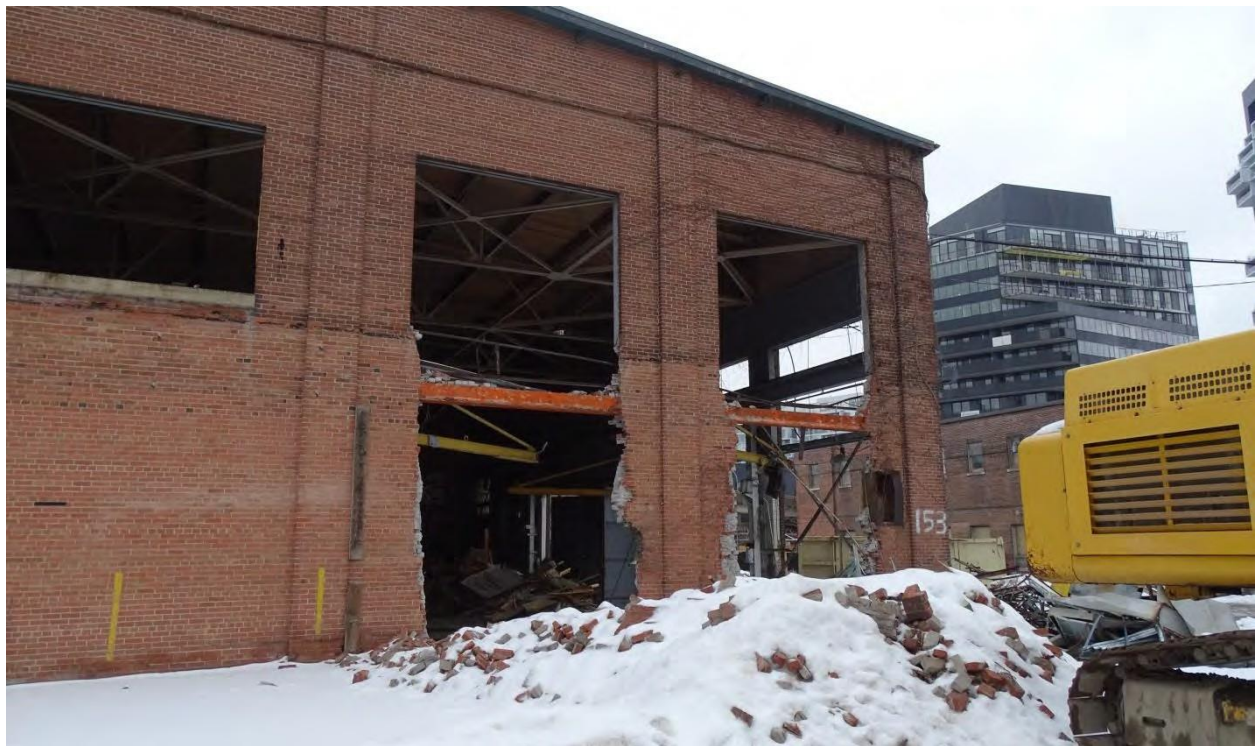
Figure 23 : Élévation sud (arrière) : Après démolition partielle. Crédit : SBA, février 2021.
