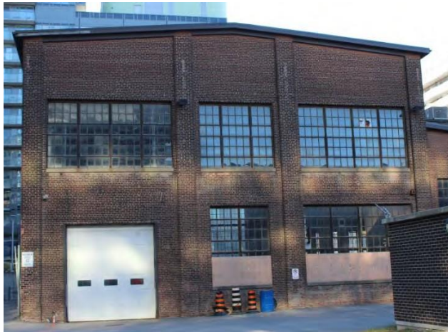
Figure 66 : 185 avenue Eastern – Atelier d'usage de 1939 – Élévation sud. Crédit : SBA, novembre 2020.
