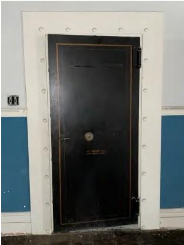
Figure 56 : Porte de voûte 2 du rez-de-chaussée – Extérieur. Crédit : SBA, novembre 2020.
