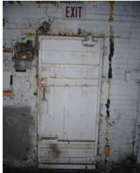
Figure 25 : Vue intérieure d'une porte en tôle d'acier, qui peut dater de la période c. 1950. Crédit : Commonwealth, 2010.
