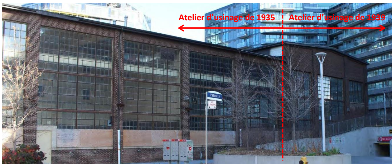
Figure 61 : 185 avenue Eastern – Atelier d'usinage de 1935 – Élévation sud. Crédit : SBA, novembre 2020.
