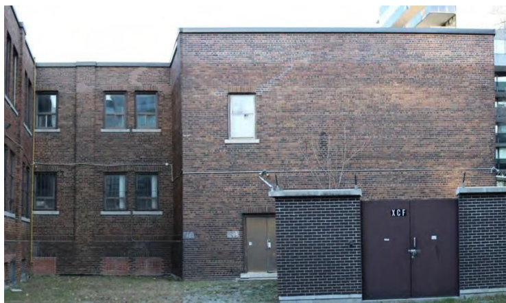
Figure 42 : 171 avenue Eastern — Bureau – Élévation sud (arrière). Crédit : SBA, novembre 2020.
