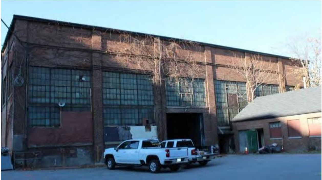
Figure 20 : Élévation (latérale) est, vue du nord-ouest : avant la démolition partielle. Crédit : SBA, novembre 2020.
