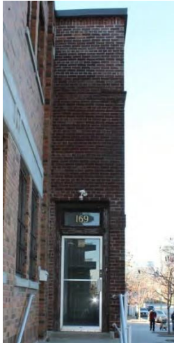
Figure 32 : 169 avenue Eastern – Entrepôt – Élévation ouest (latérale). Crédit : SBA, novembre 2020.
