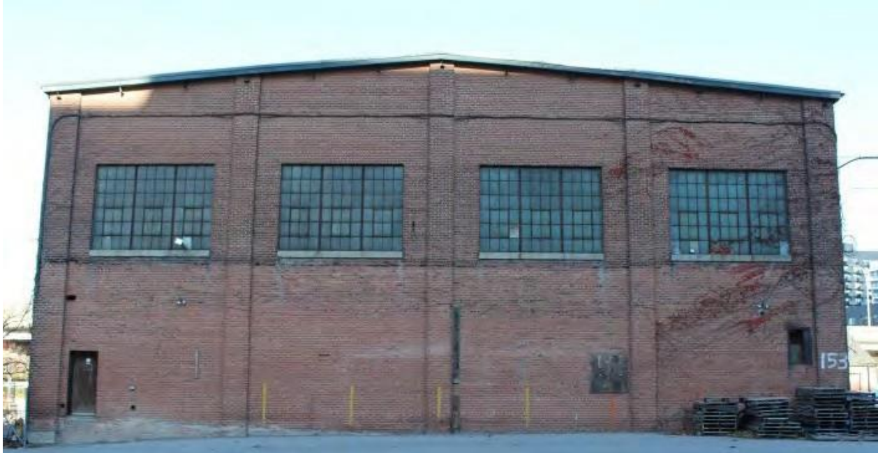
Figure 22 : Élévation sud (arrière) : Avant la démolition partielle. Crédit : SBA, novembre 2020.
