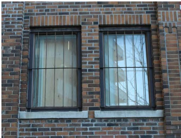
Figure 45 : Remplacement typique de fenêtres – Élévation nord – Rez-de-chaussée.
