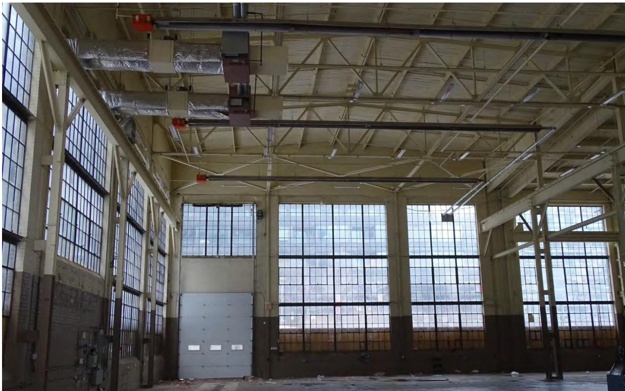
Figure 76 : Atelier d'usinage de 1939 montrant la structure des équipements. Crédit : SBA, novembre 2020.
