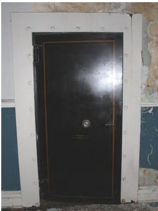
Figure 54 : Porte de voûte 1 du rez-de-chaussée – Extérieur. Crédit : SBA, novembre 2020.
