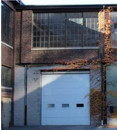
Figure 63 : 185 avenue Eastern – Atelier d'usinage de 1935 et ajout des années 1940 – Élévation sud. Crédit : SBA, novembre 2020.
