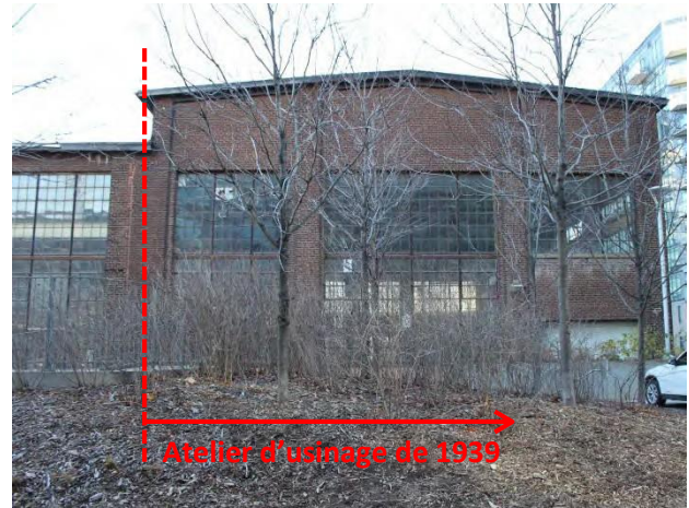
Figure 67 : 185 avenue Eastern – Atelier d'usage de 1939 – Élévation sud. (Niveau du rez-de-chaussée caché par le mur de soutènement voisin). Crédit : SBA, novembre 2020.
