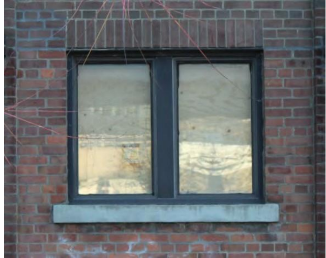
Figure 35 : Remplacement des fenêtres à l'emplacement de l'entrée d'origine. Crédit : SBA, novembre 2020.
