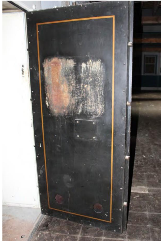
Figure 57 : Porte de voûte 2 du rez-de-chaussée – Intérieur. Crédit : SBA, novembre 2020.
