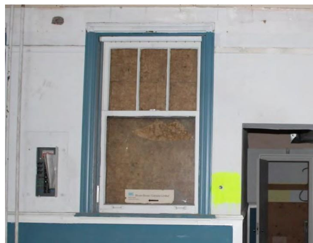
Figure 48 : Fenêtre originale située à l'intérieur.
