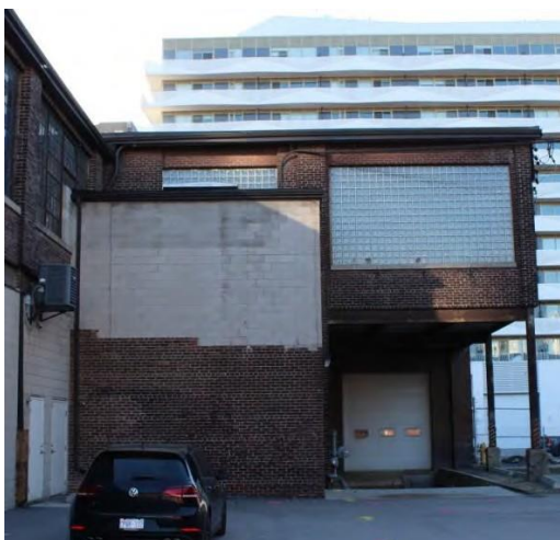
Figure 65 : 185 avenue Eastern – Atelier d'usinage de 1935 et ajout des années 1940 – Élévation sud. Crédit : SBA, novembre 2020.
