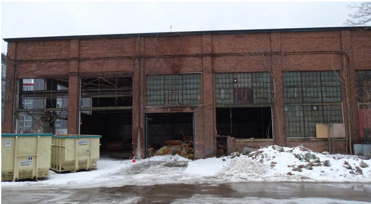
Figure 21 : Élévation (latérale) est : Après démolition partielle. Crédit : SBA, février 2021.
