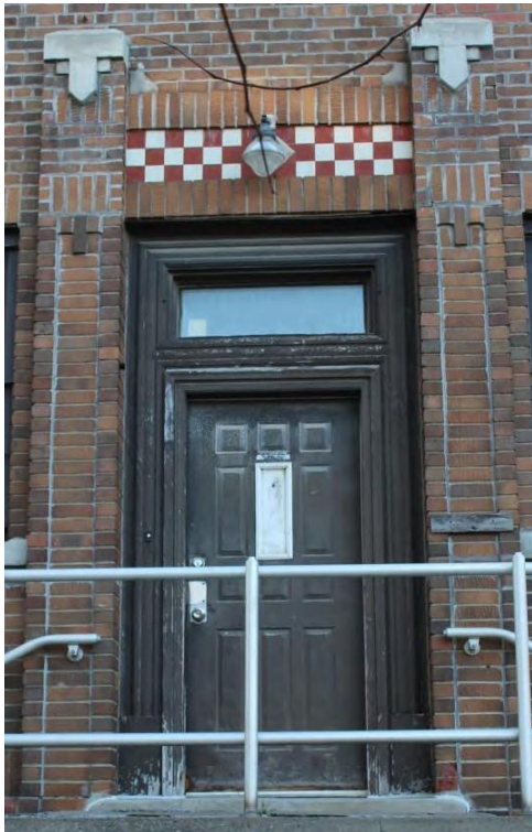
Figure 49 : Entrée principale sur l'avenue Eastern. Crédit : SBA, novembre 2020.
