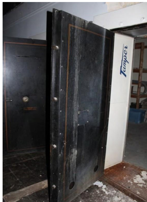
Figure 55 : Porte de voûte 1 du rez-de-chaussée – Intérieur. Crédit : SBA, novembre 2020.
