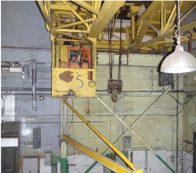
Figure 28 : Grue portique à l'angle nord-ouest. Crédit : SBA, novembre 2020.
